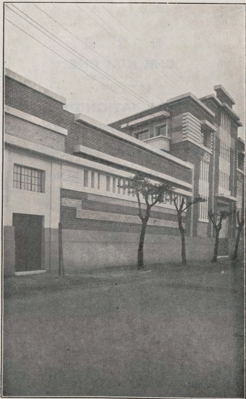
1—Vue extérieure de l'immeuble de "CHE KIAI CHE" (Entrée de la rue Ferguson)
